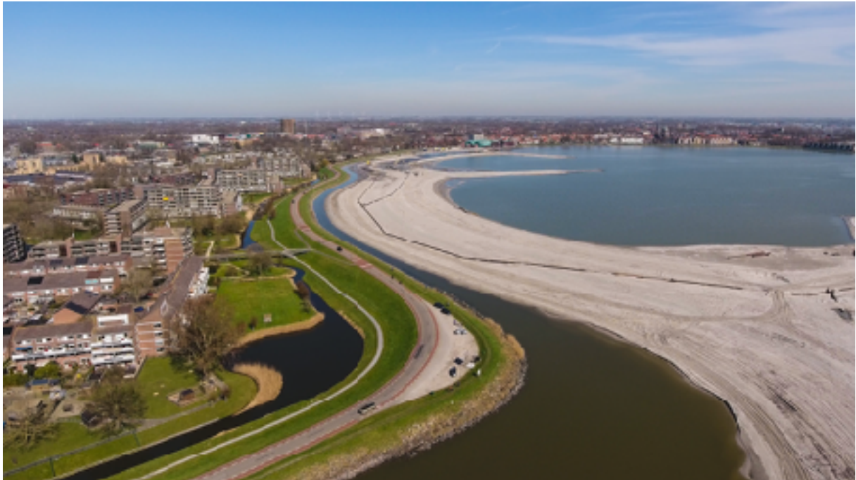
Hoorn, Westerdijk, dijkversterking en aanleg stadsstrand, maart 2021
